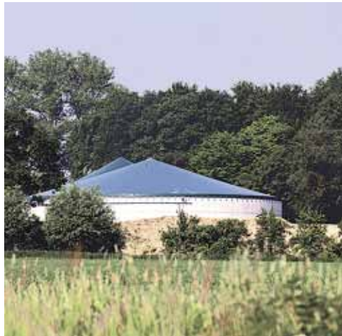
— Kupoltäckta svämbrunnar. Taket är av presenningstyp på stålkonstruktion. Går att eftermontera. —
