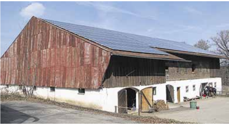
Hela den södra takhalvan på det här gamla tyska stallet har man täckt med solceller.
