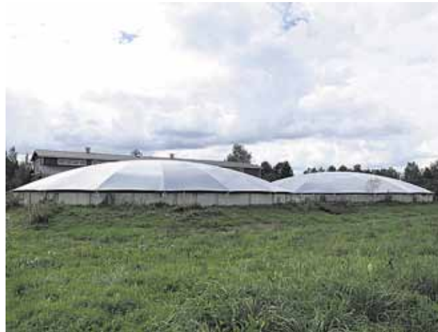
— Kupoltäckta svämbrunnar. Taket är av presenningstyp på stålkonstruktion. Går att eftermontera. —
