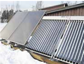
Planfångare och vakuumrörfångare börjar producera hyggligt med värme redan i början av mars. Värmeförlusterna från vakuumrörfångare är så små att snön hålls kvar på dem.
