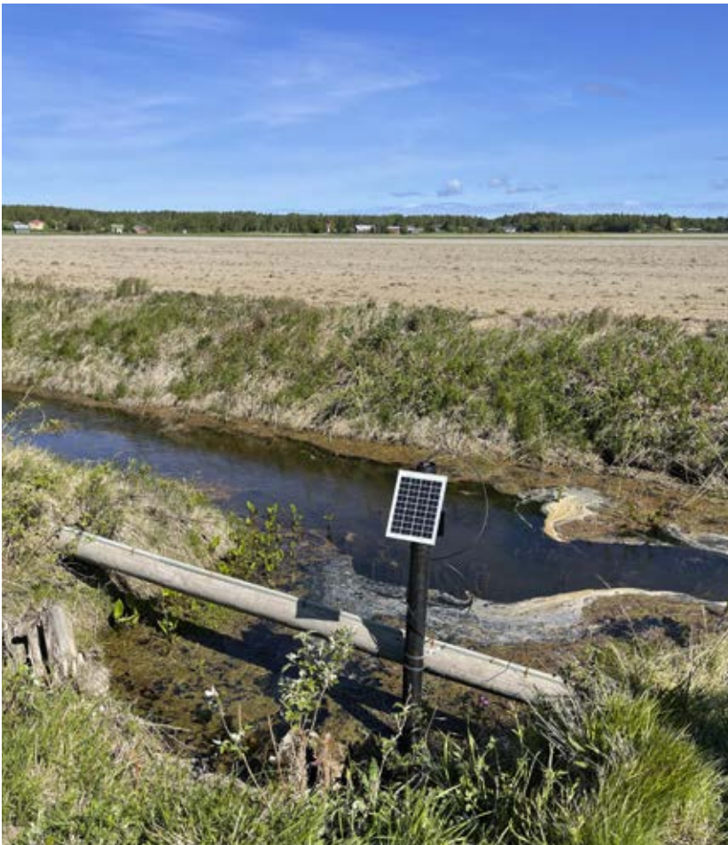
Mätstation i utfall.
