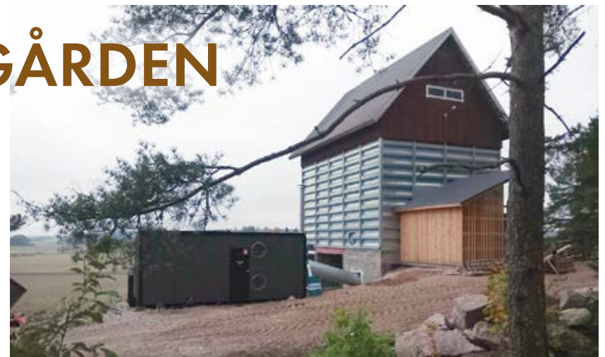
Spannmålstorkning med en containermonterad fliseldad hetluftspanna.
