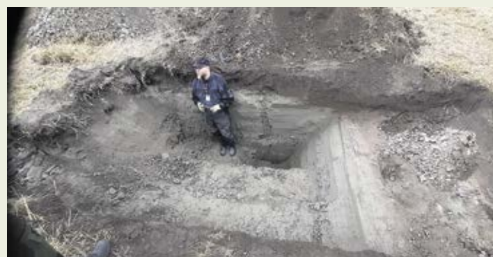
En större grop för att kolla strukturen på djupet, notera avsatserna för ett säkrare arbete.
