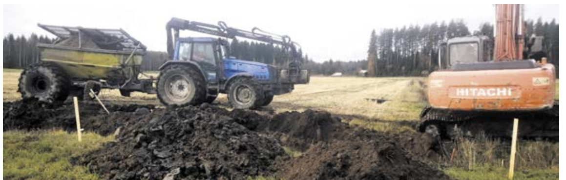
Entreprenör Tapio Salo gräver ner ett 200 mm rör med grävmaskin vid Stavmossen. Foto Mikael Blomqvist
