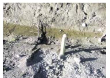
Spoluttag installeras med skyddsrör ca 50 cm under markytan. Foto Mikael Blomqvist
