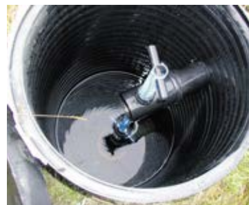
Regleringsbrunnar inverkar gynnsamt på vattenhushållningen och motverkar rostbildning i rörsystemen. Foto Rainer Rosendahl
